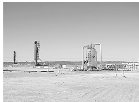
称重式油井计量器项目现场照片
